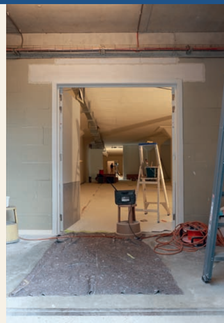
Nieuwe deuropeningen voor depot 212 (foto Storm Calle, Archief Gent)
