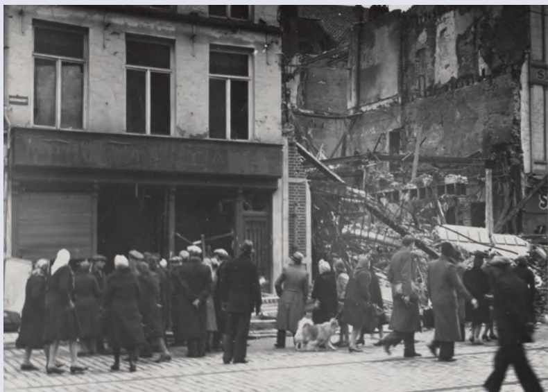
De oude gebouwen van de Sarma na de brand van 26 januari 1946 (SCMS_FO_3001)
