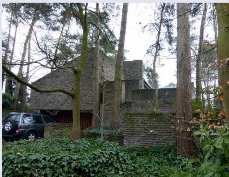
Architectenwoning Jos Van Driessche (1972-1975), Pieter Pauwel Rubenslaan 18, Sint-Denijs-Westrem. (Onroerend Erfgoed, Inventaris van het Bouwkundig Erfgoed, © Vlaamse Gemeenschap)
