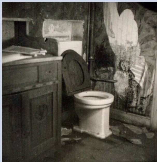
Kasteel Morek met bijgebouwen aan de Winkelstraat 7 (nu 21) in Wondelgem. Schade ten gevolge van de bezetting door verschillende legers tijdens de Tweede Wereldoorlog en beschietingen in september 1944 (Rijksarchief Gent, Oorlogsschade private goederen provinciale reeks Oost-Vlaanderen, nr. 4.068.735)
